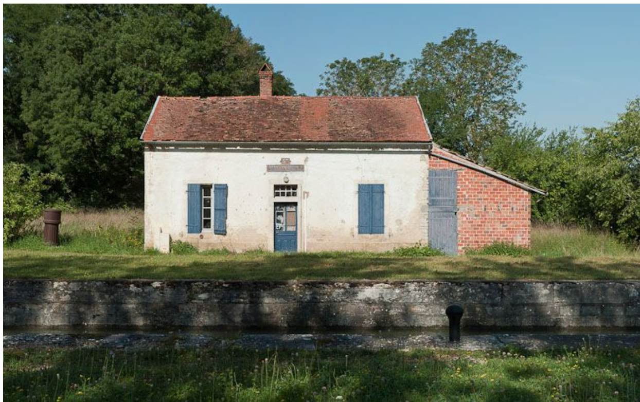
Vue de face de la maison éclusière.
