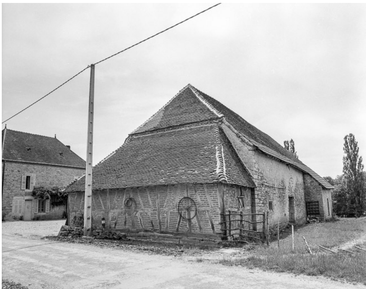
Bâtiment d'exploitation, façade postérieure et face droite.
