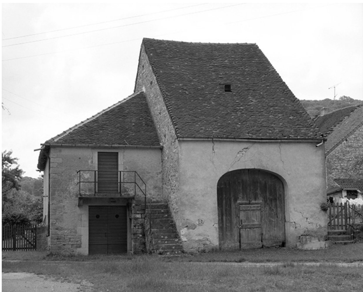
Ferme : façade postérieure.
