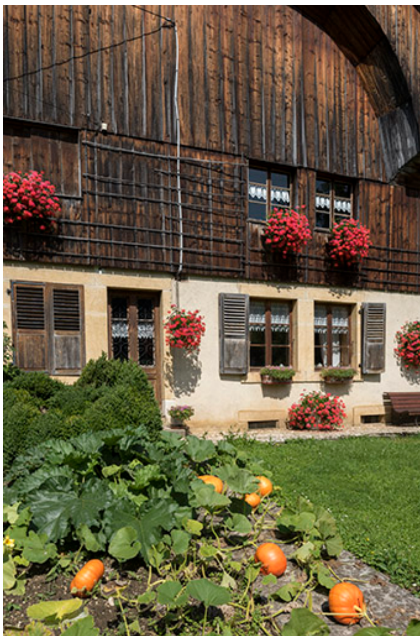
Ferme, façade antérieure : baies et lambrichure.
