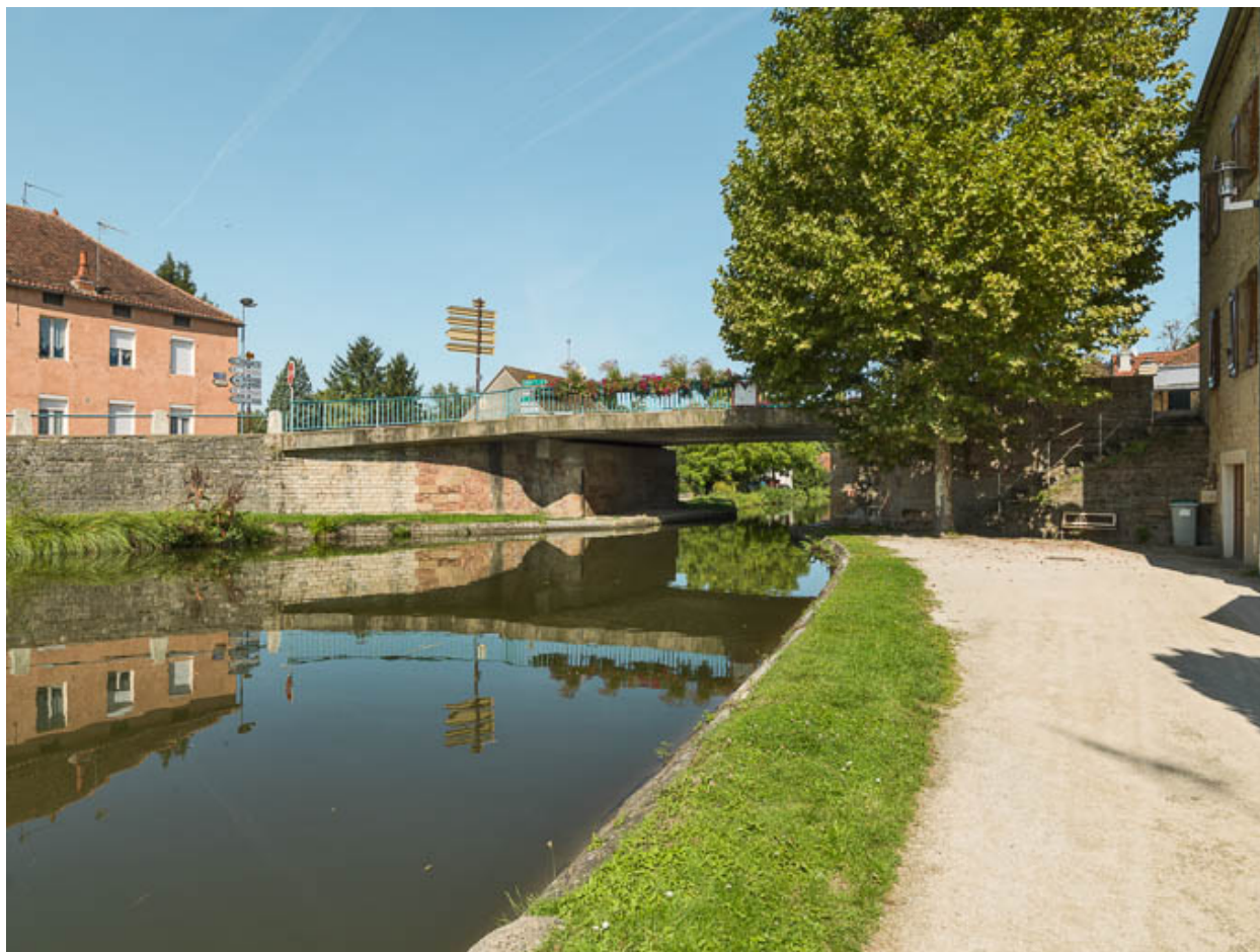
Vue d'ensemble du pont.
