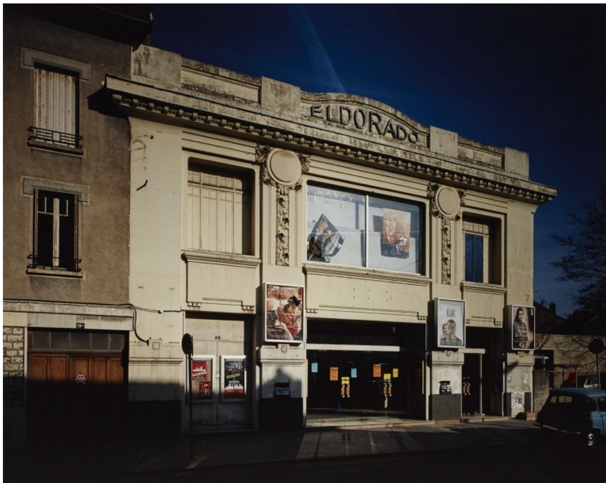
Vue d'ensemble de la façade en 1994.
