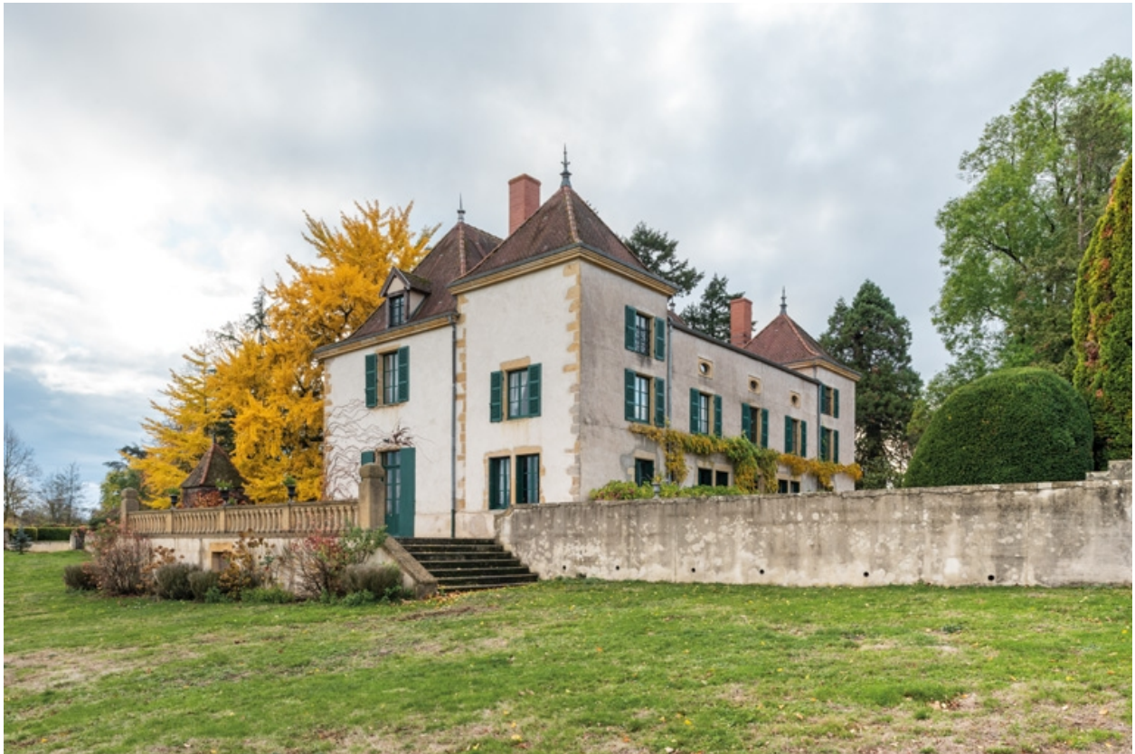
Château : vue de l'est
