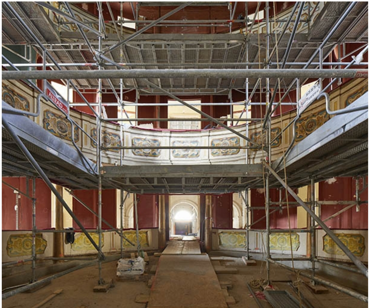
Echafaudage dans la salle, en 2020.
