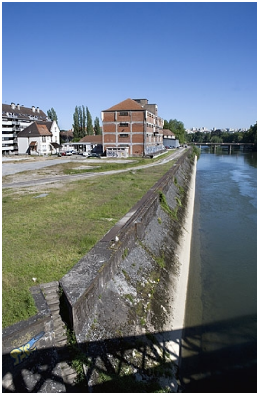
Entrepôt et quai, depuis l'amont.
