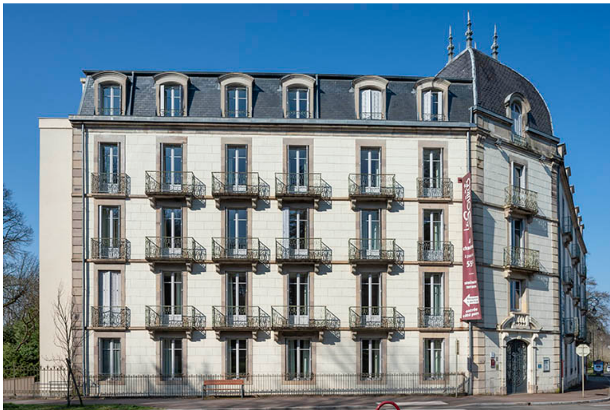
Façade sur rue de l'aile sud.
