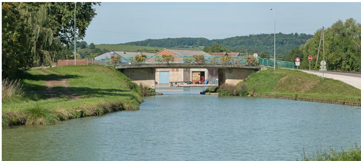
Vue du pont depuis l'amont.
