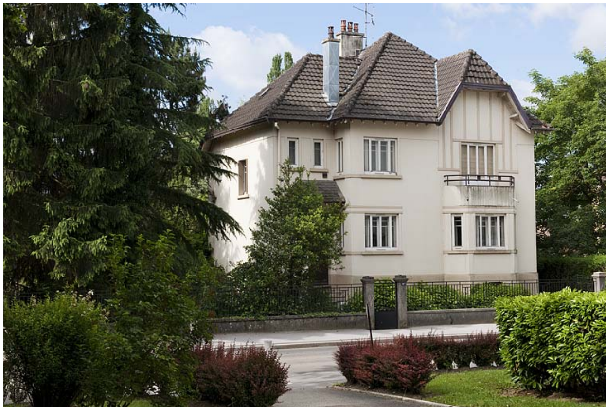
Logement patronal. Vue de trois quarts.
