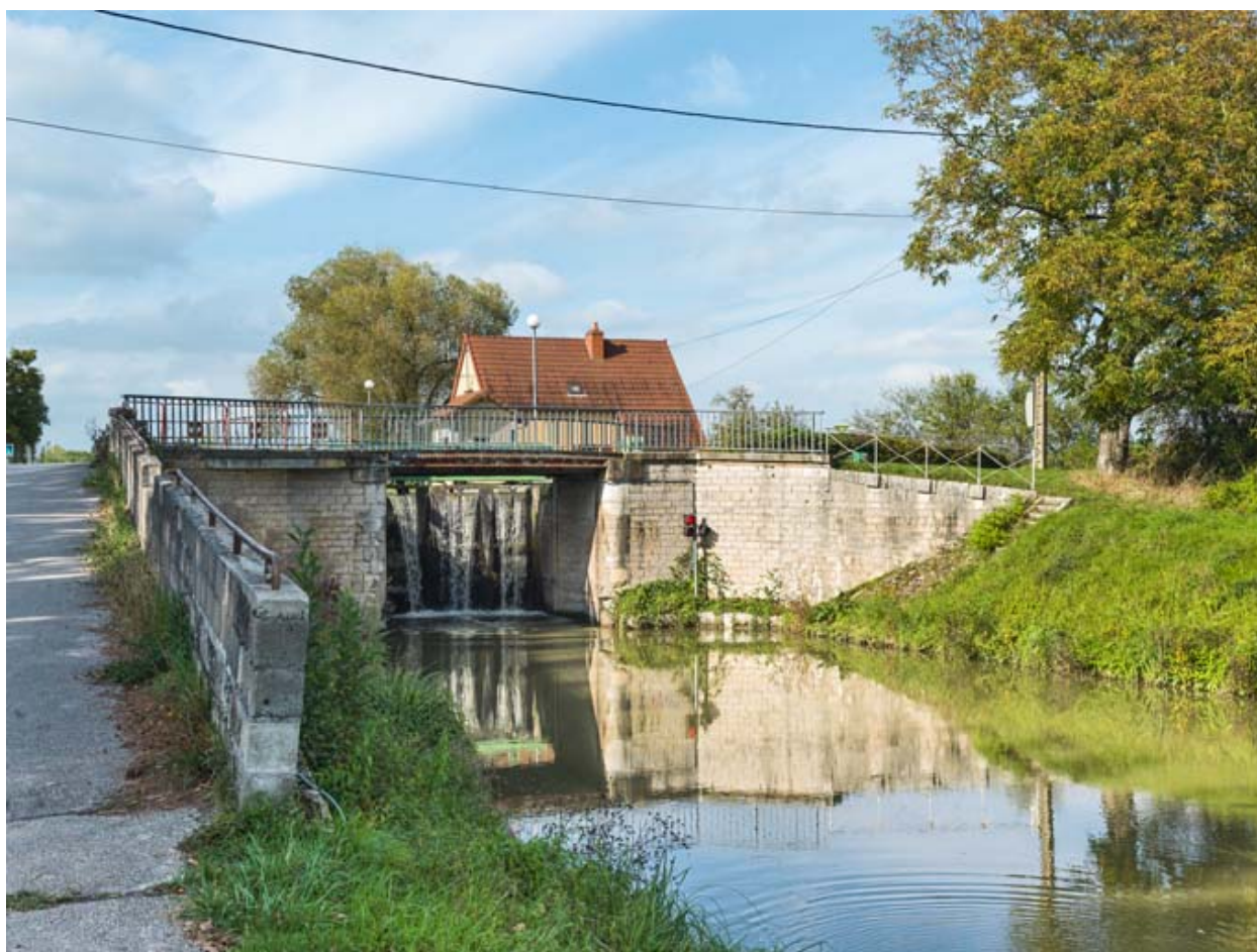
Vue d'ensemble du pont.
