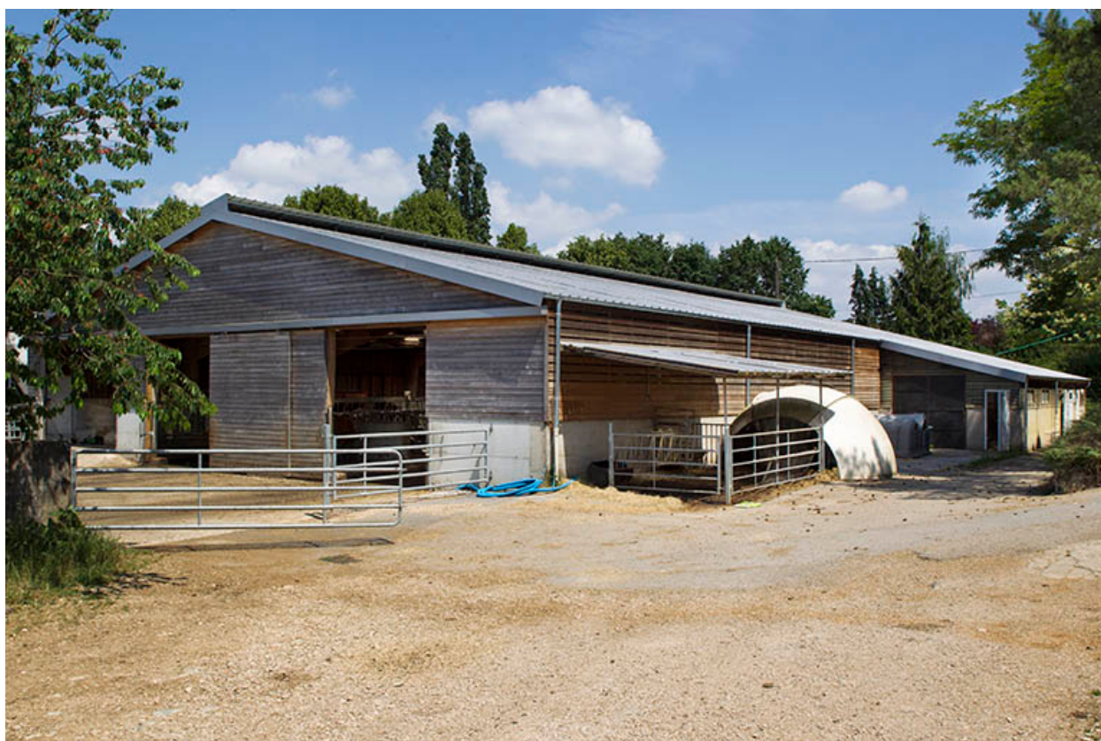
L'étable ouest vue de trois-quart sud-est.
