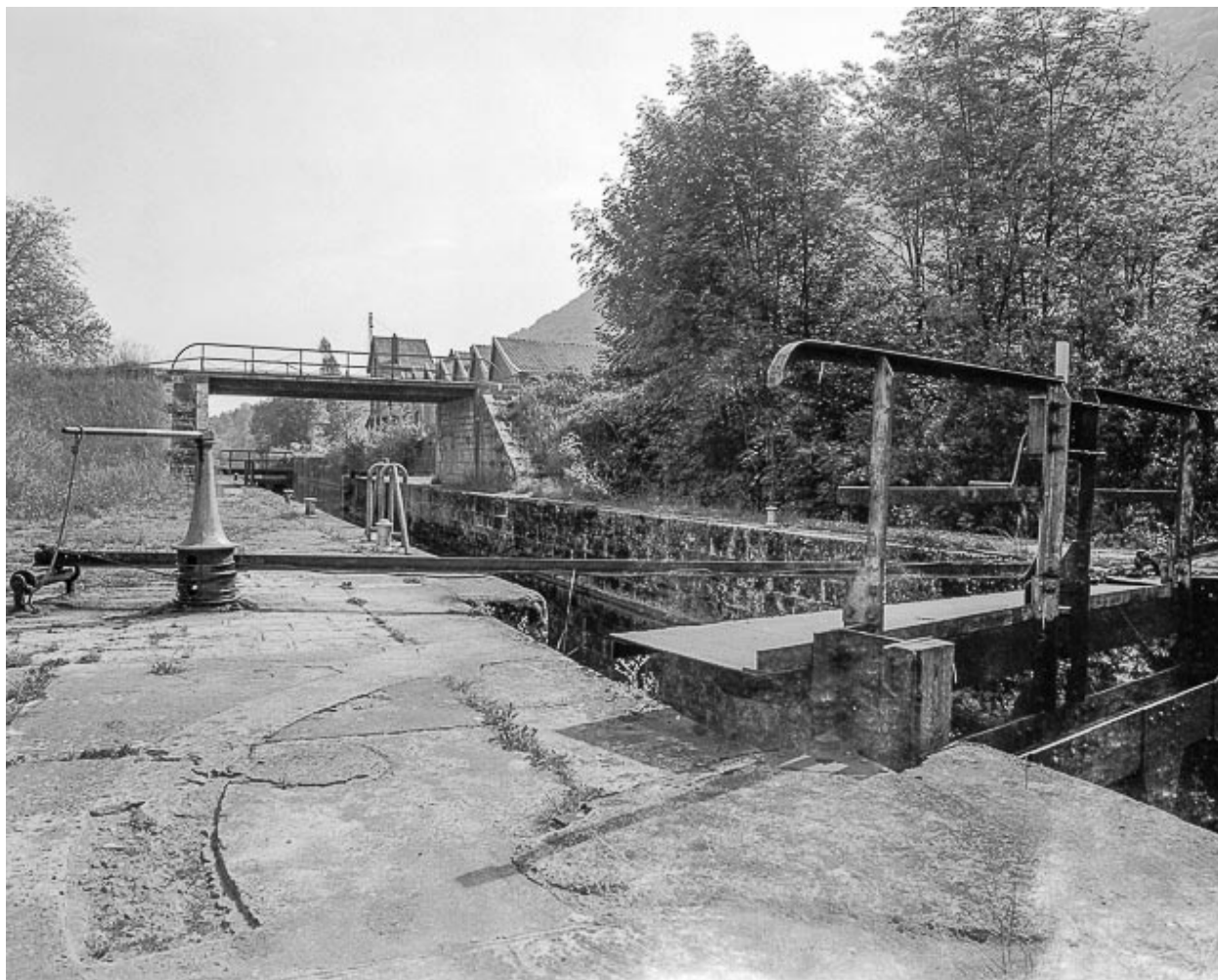
L'usine depuis la porte aval de l'écluse en 1976.
