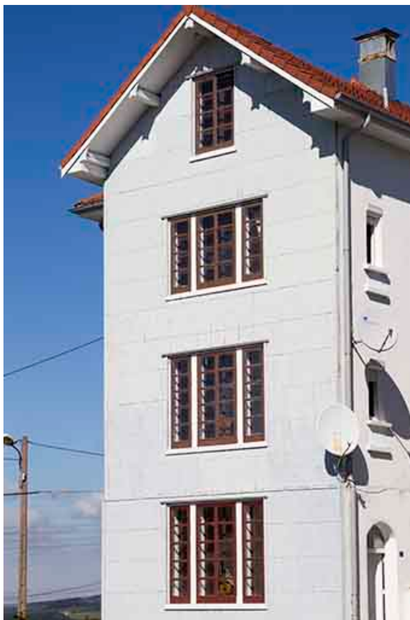
Atelier de 1948 : baies du mur pignon oriental.
