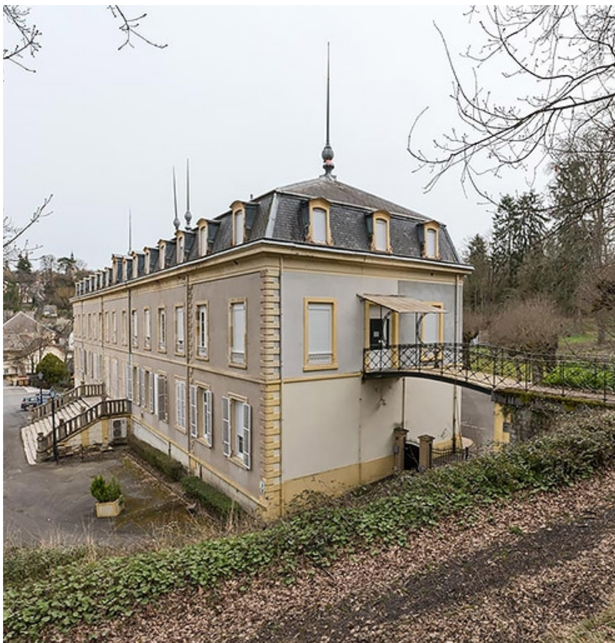
Aile nord, vue d'ensemble.
