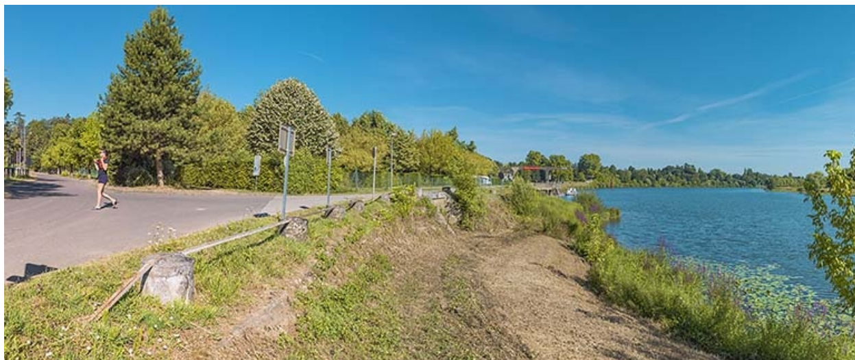
Perrés en aval du port de Gergy.
