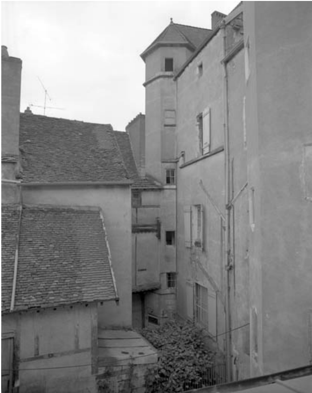
Façade postérieure depuis l'arrière-cour du 99 Grande rue.
