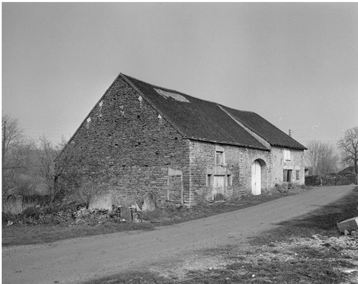
Façade antérieure et pignon gauche.
