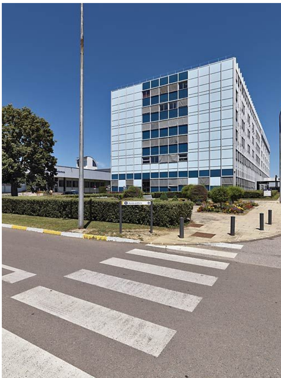
Bâtiment principal, vue d'ensemble de trois-quarts.
