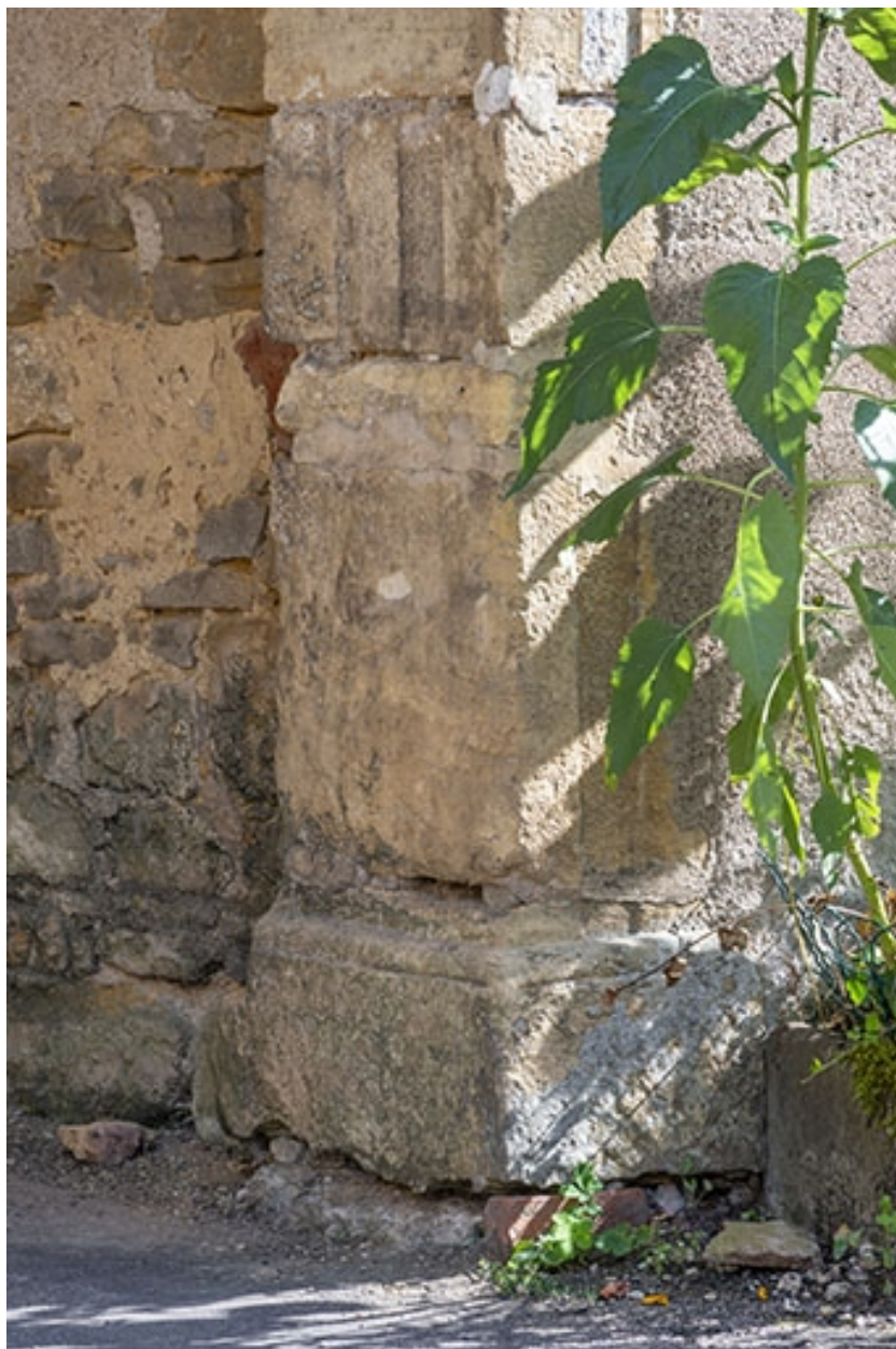
La base du piédroit du portail.
