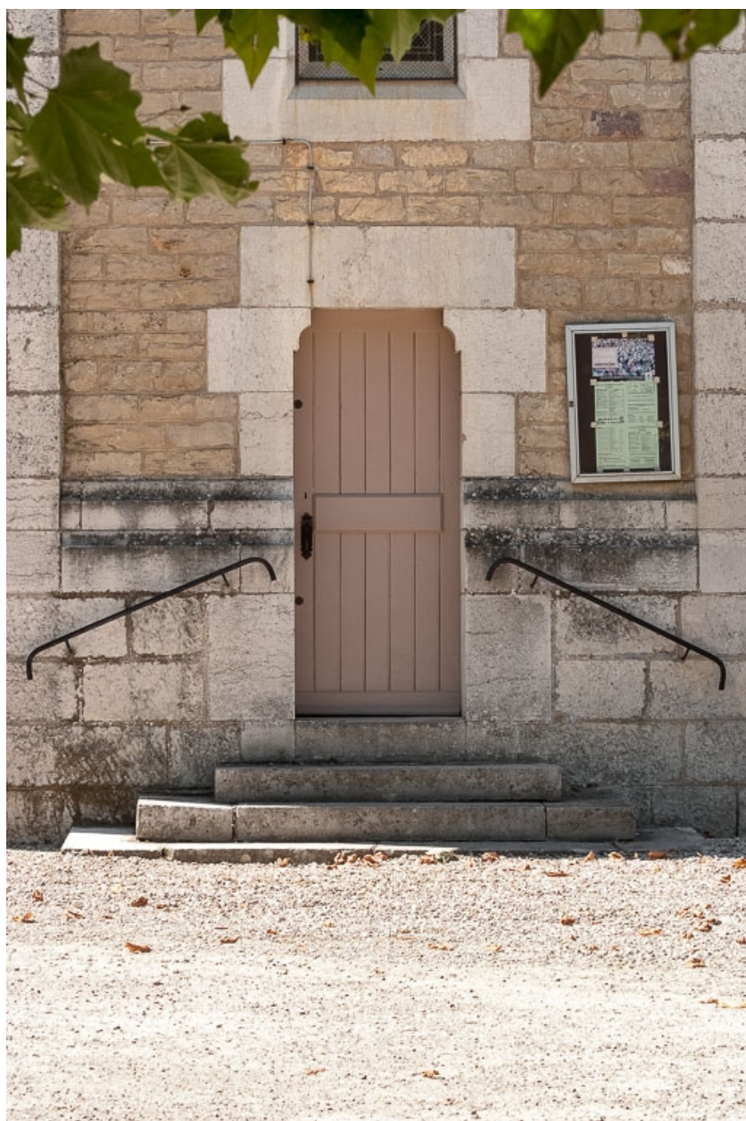
Porte latérale , élévation est.
