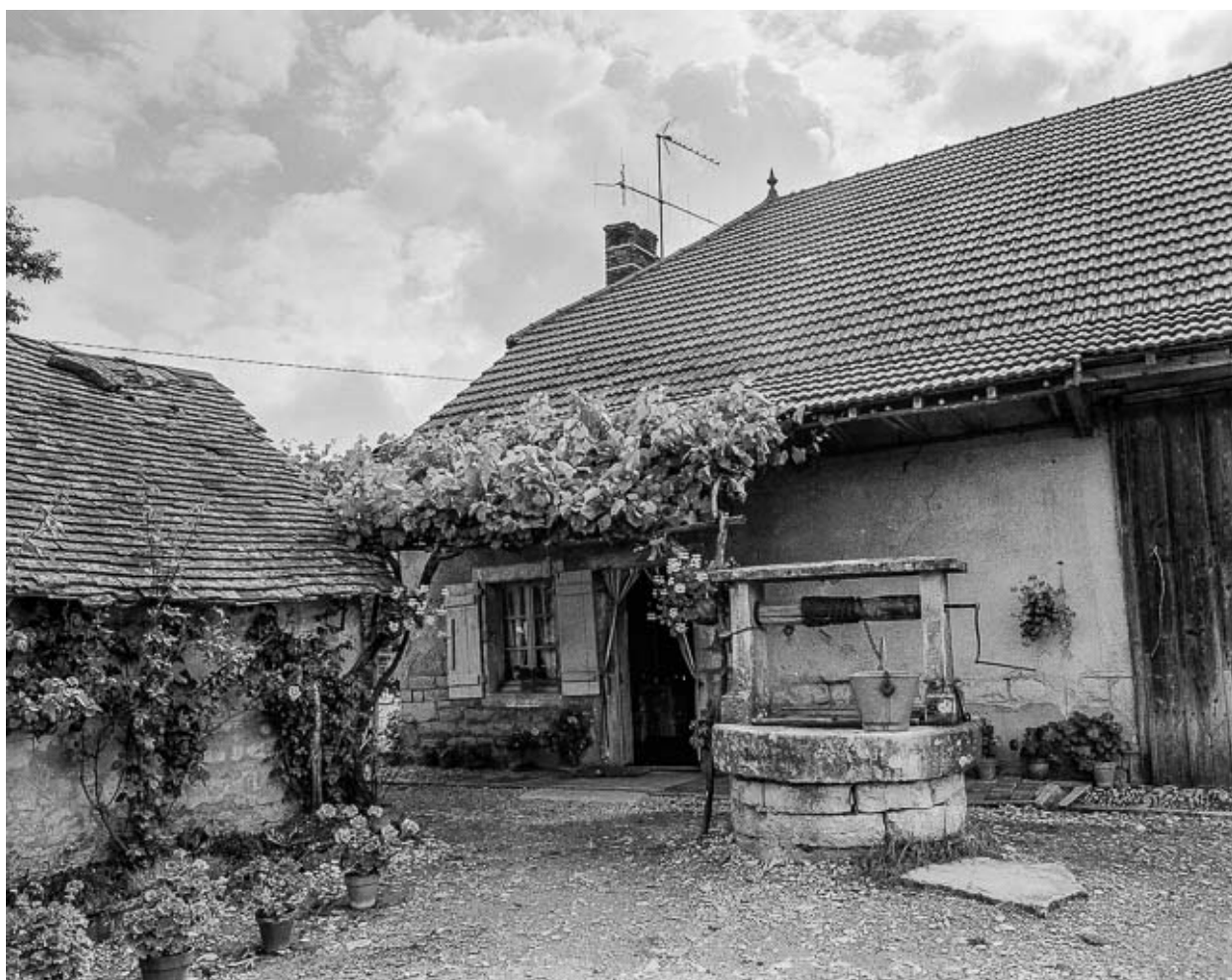
Relans : ferme avec puits dans la cour.
