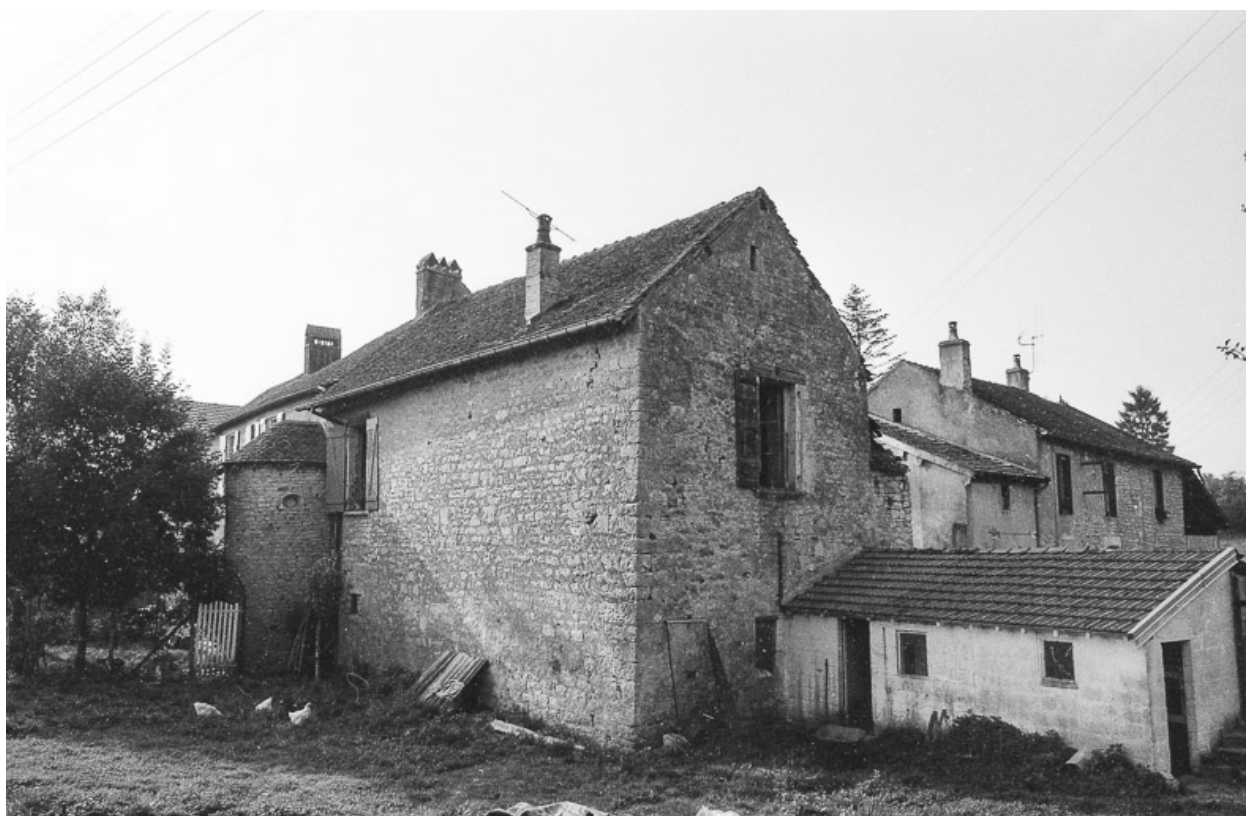
Façade latérale droite.
