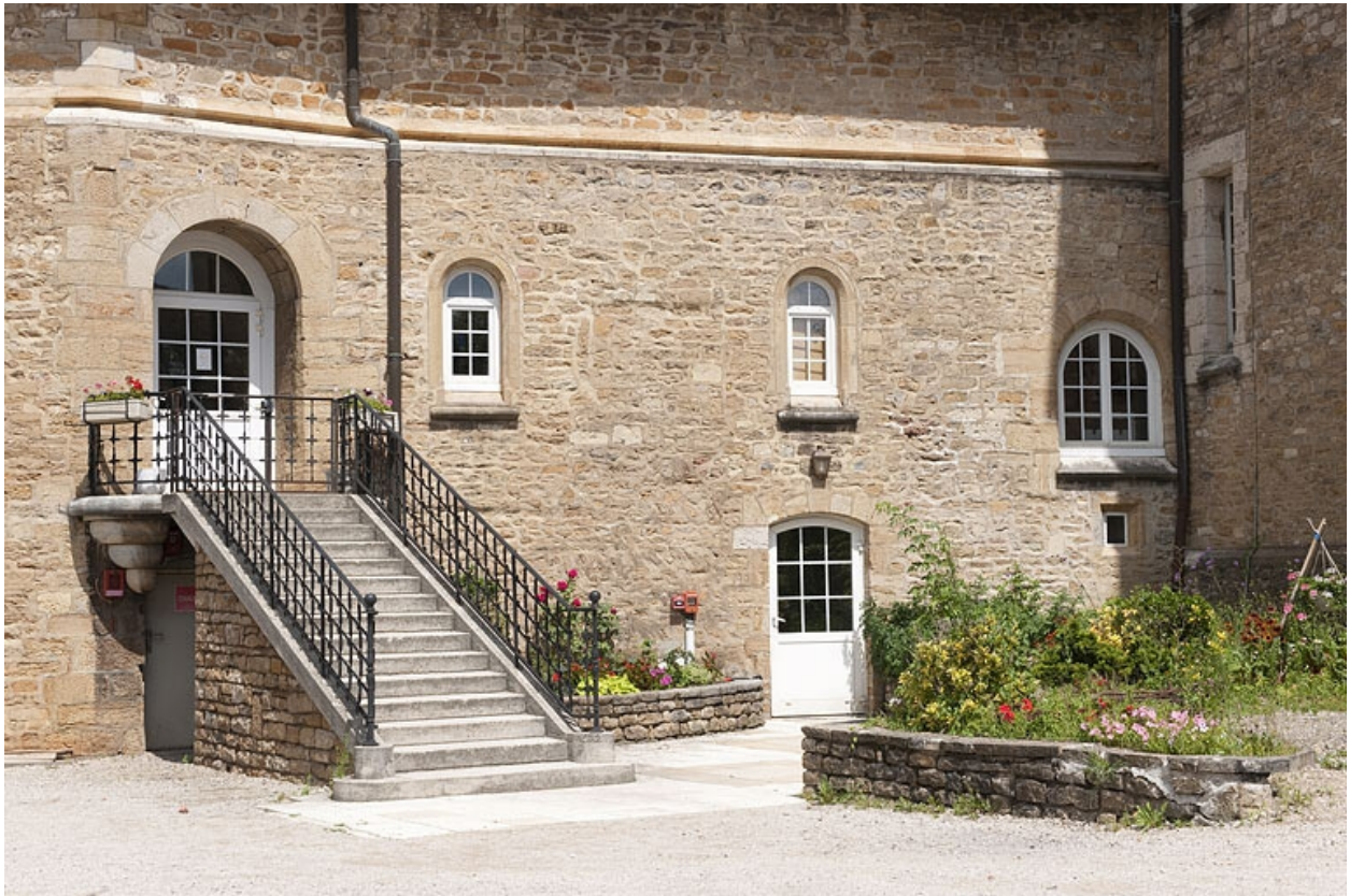
Bâtiment (C), escalier côté cour.
