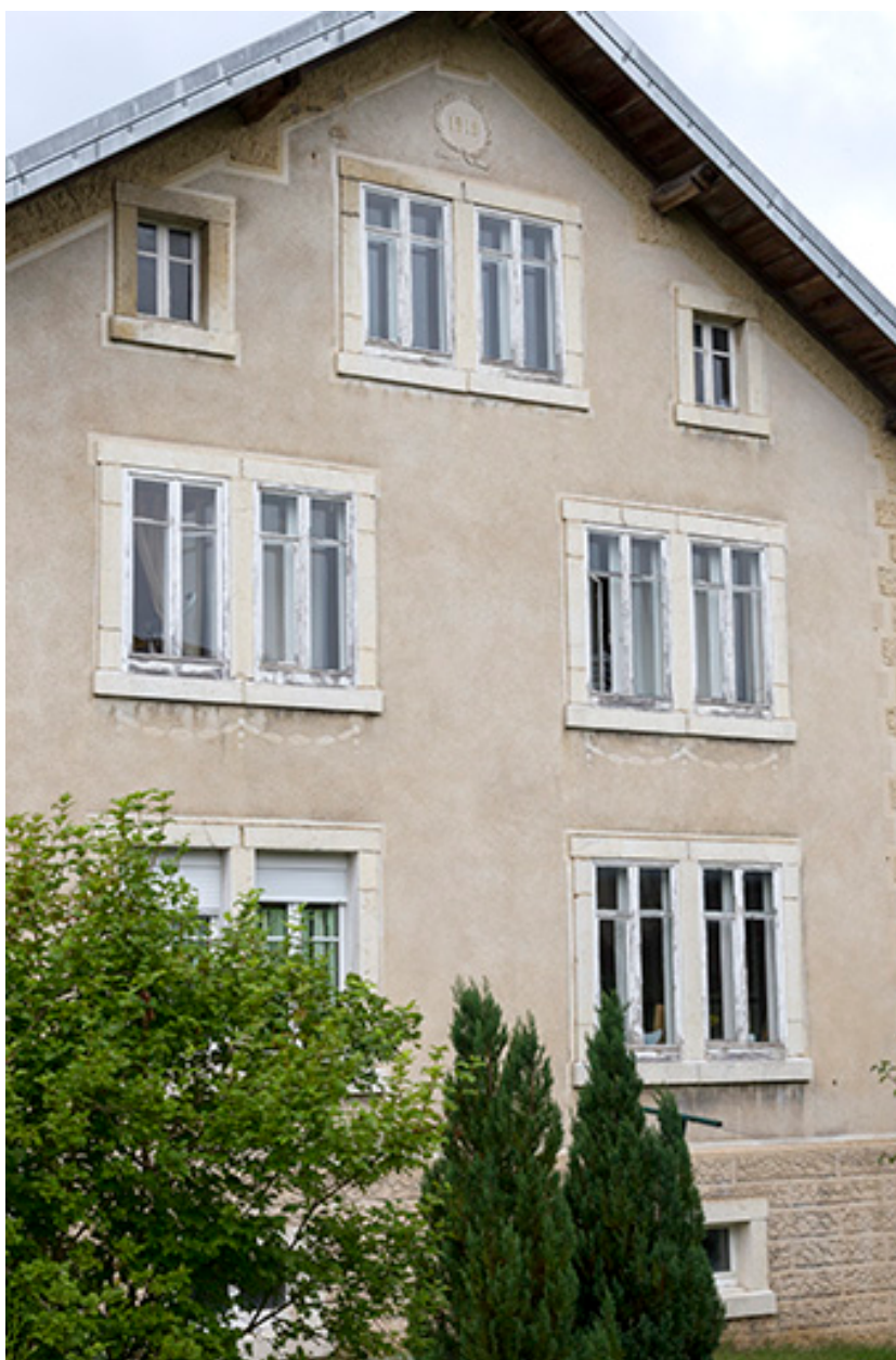
Façade latérale droite, de trois quarts gauche.
