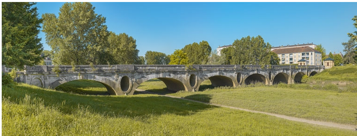
Vue d'ensemble du pont des Chavannes.
