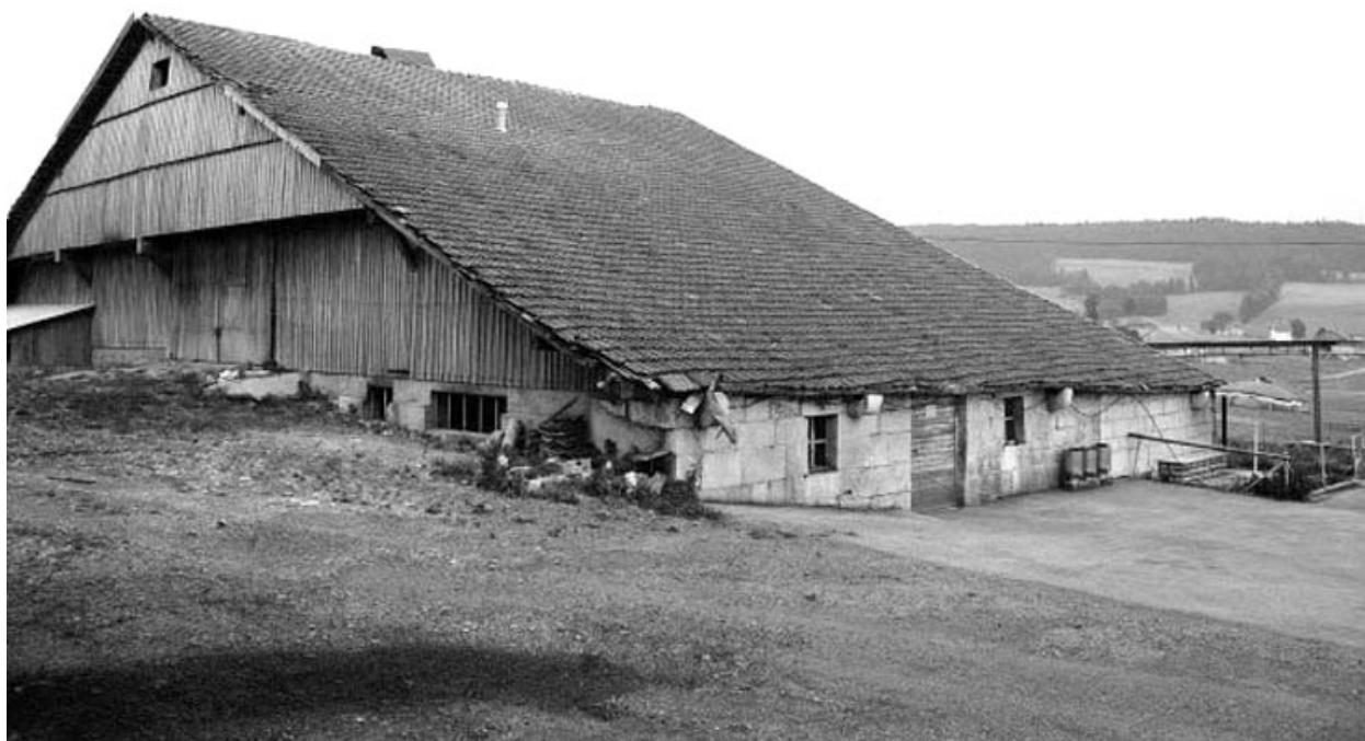
Facades postérieure et latérale gauche.
