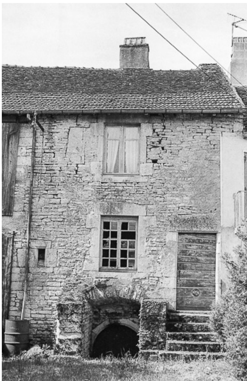
Détail de la partie habitation.
