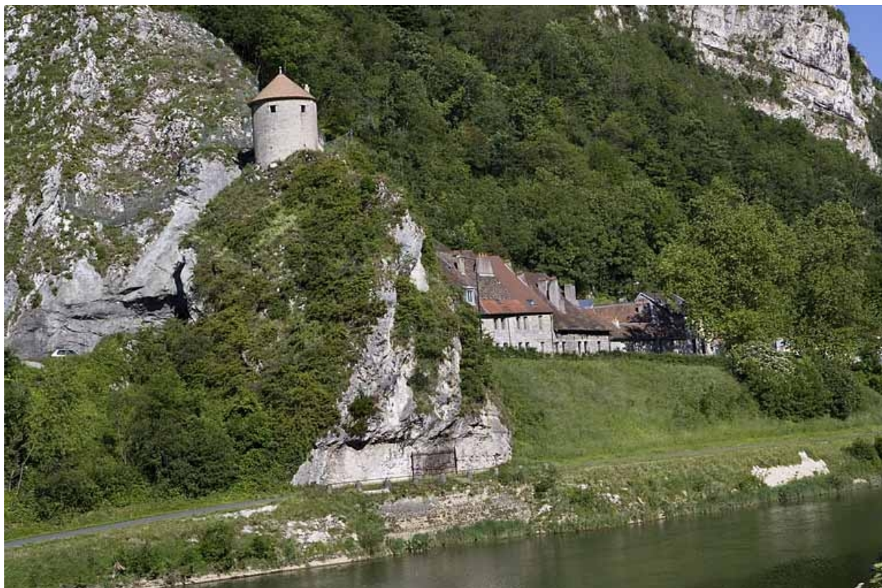
Vue d'ensemble rapprochée du quai.
