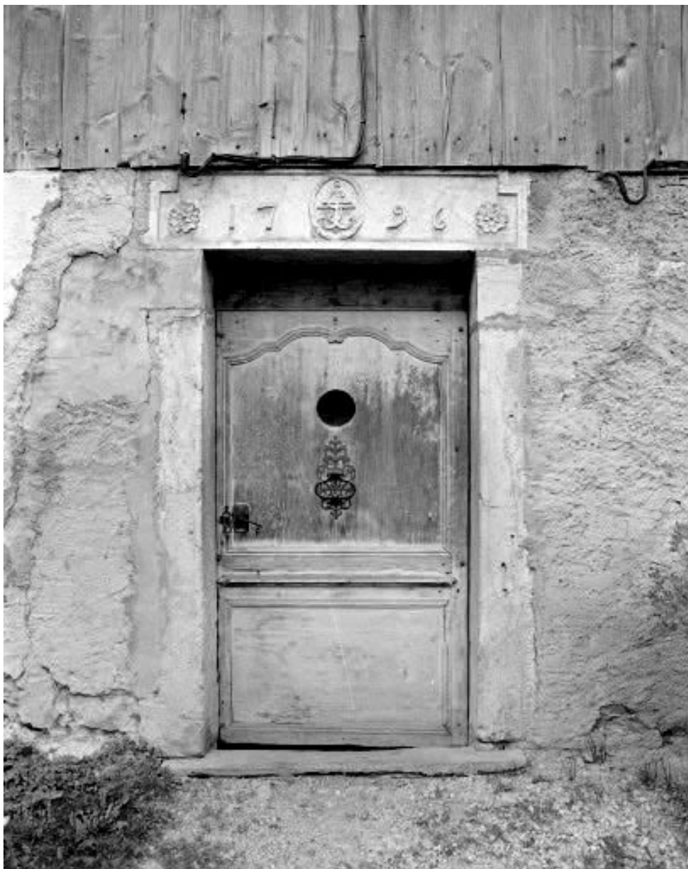
Façade antérieure : porte d'entrée.
