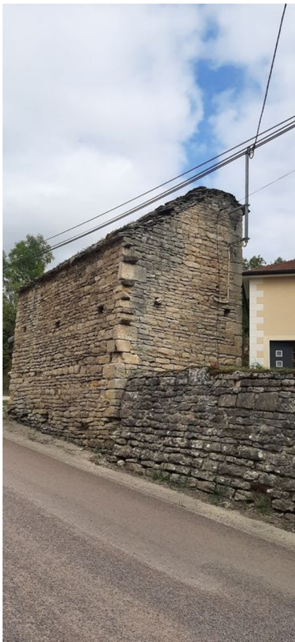
Vue de la construction depuis le sud.
