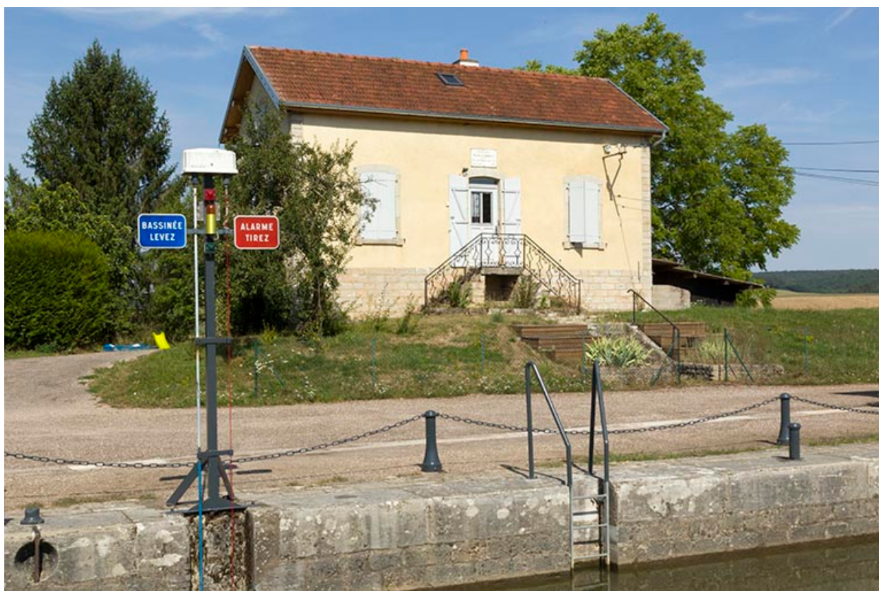
Vue de face de la maison d'éclusier.
