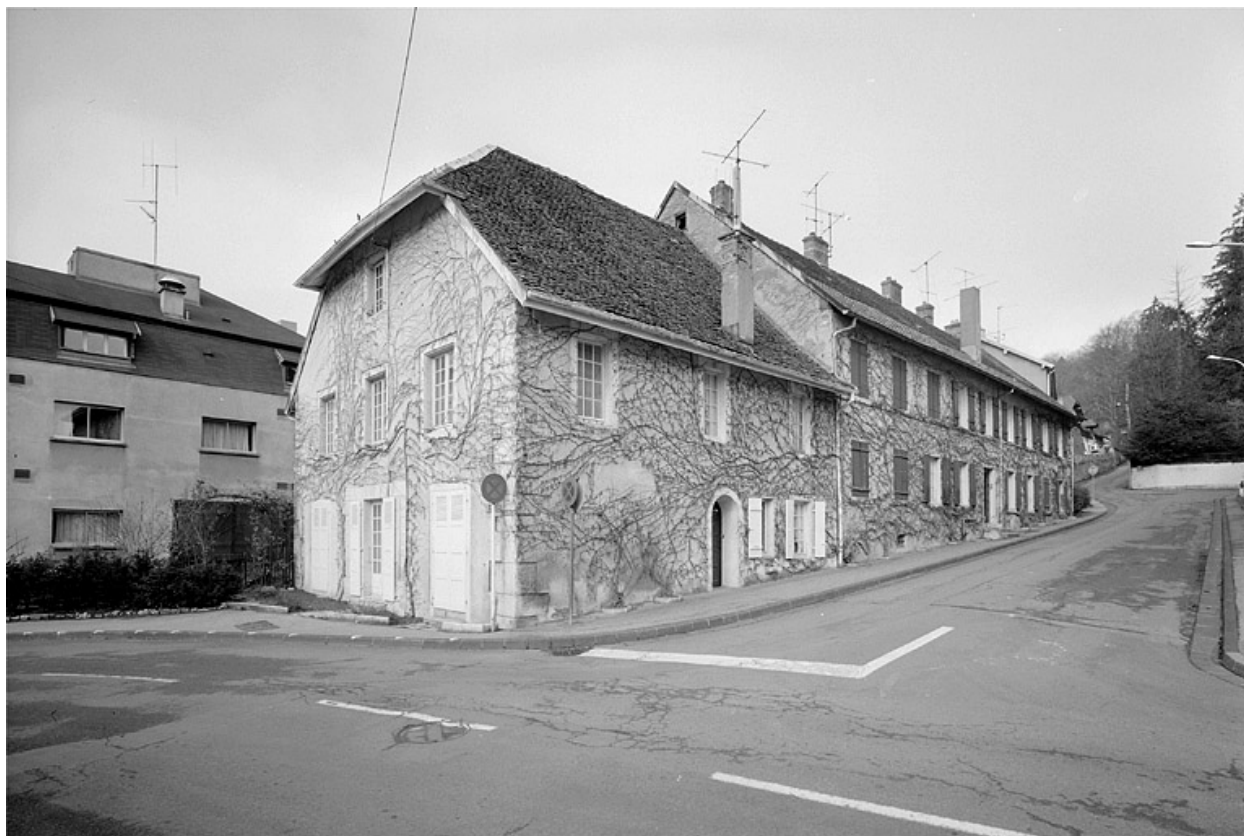
Vue d'ensemble des façades sud et est.
