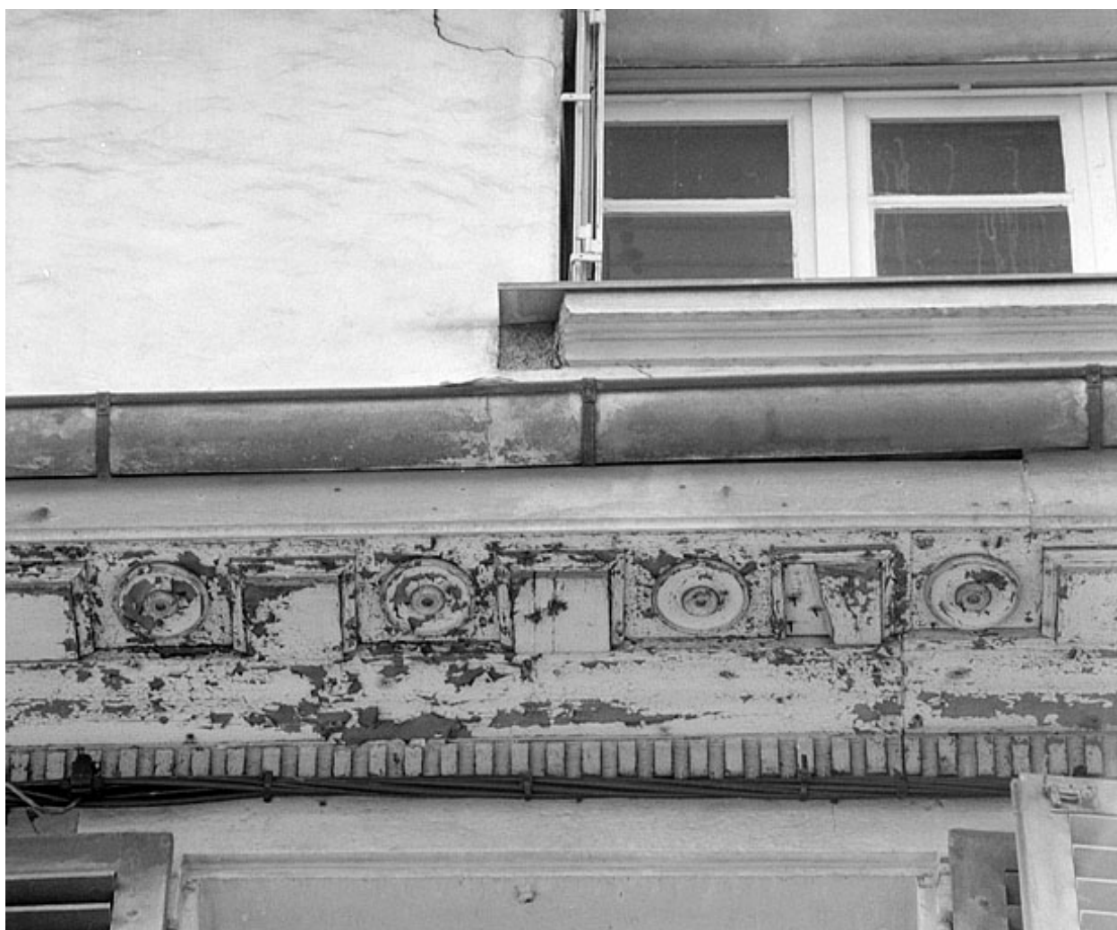
Façade sur rue. Détail de la corniche.
