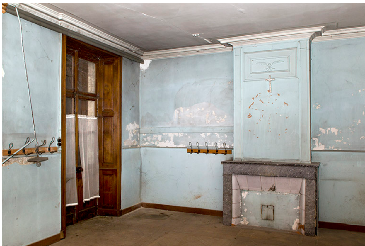
Une chambre en rez-de-chaussée.
