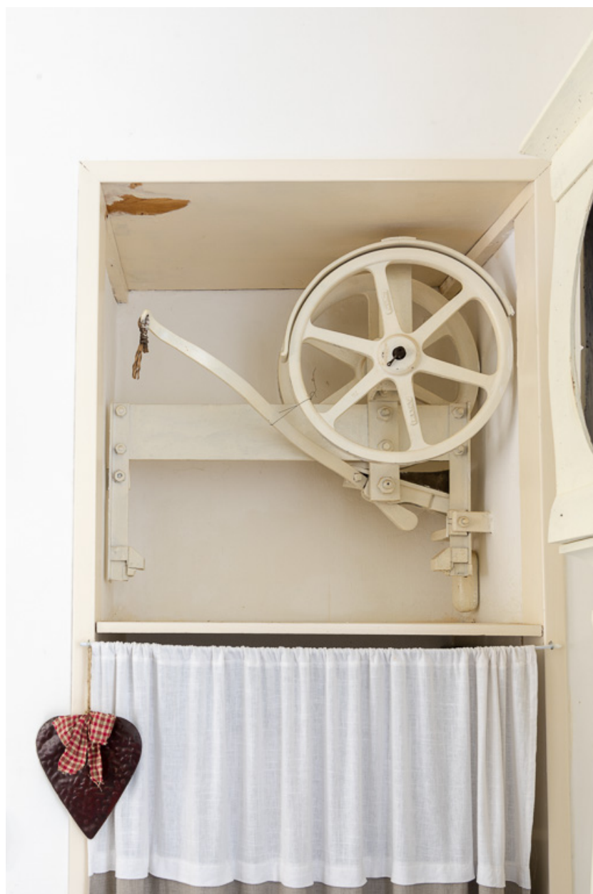
Mécanisme de monte-charge.
