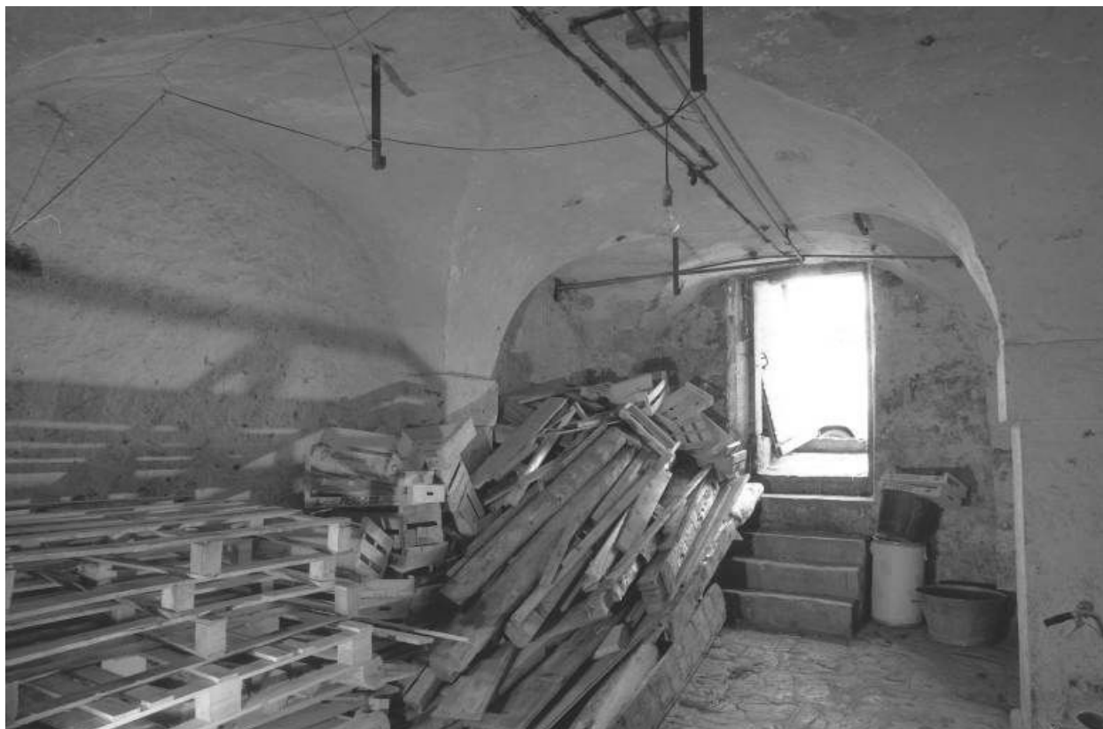
Pièce voûtée, en sous-sol.
