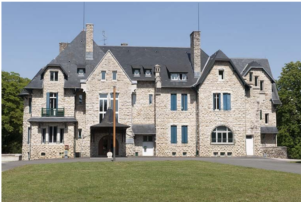
Façade antérieure vue de face.
