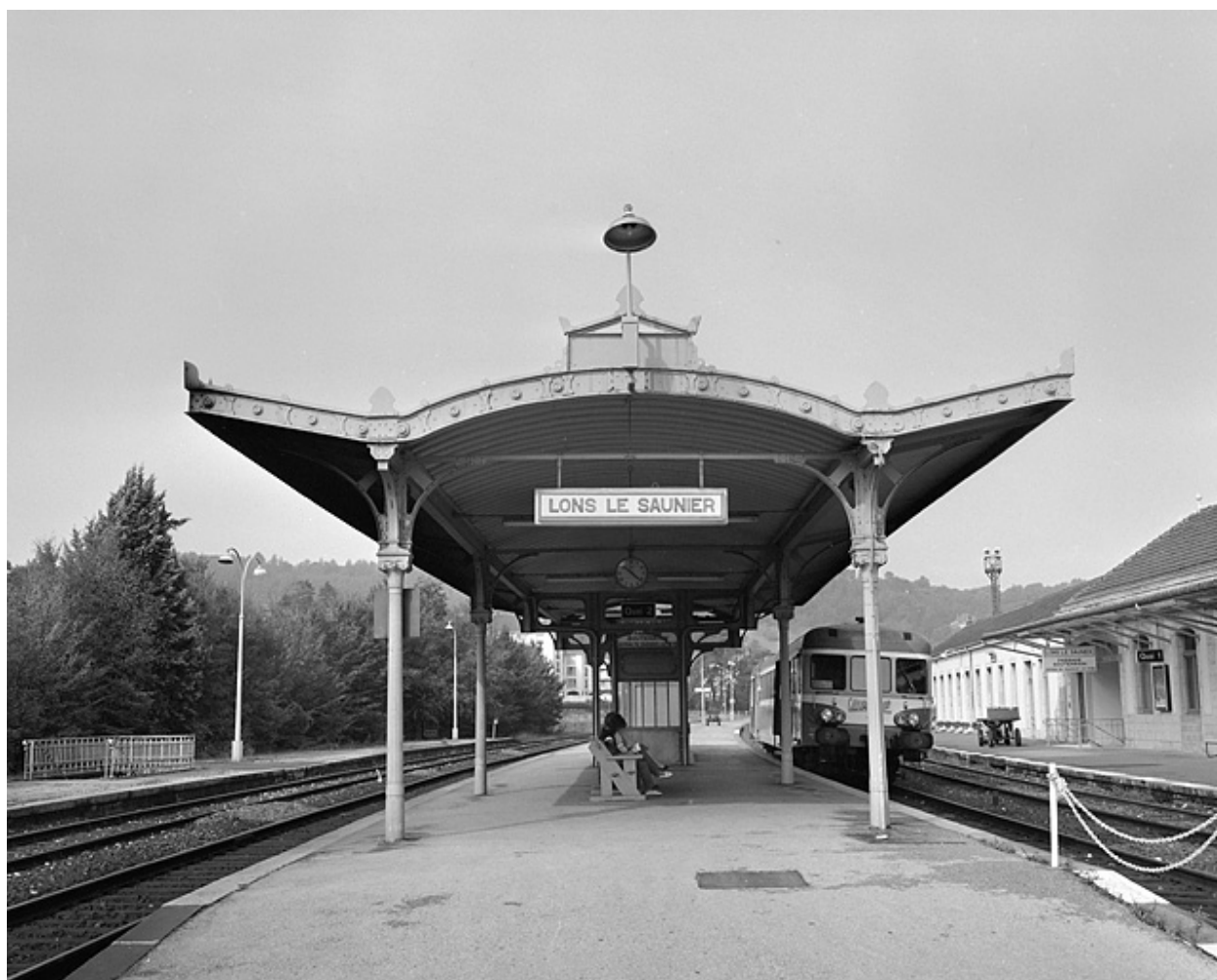
Abri métallique sur le quai.
