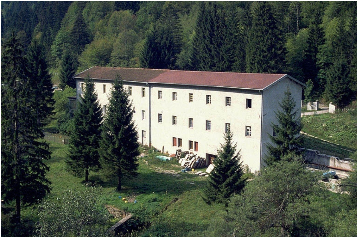
Vue d'ensemble depuis l'est (façade postérieure).
