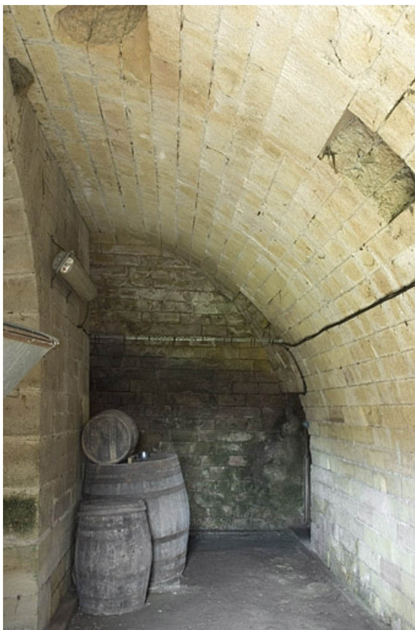
Couloir de circulation voûté d'un demi-berceau.
