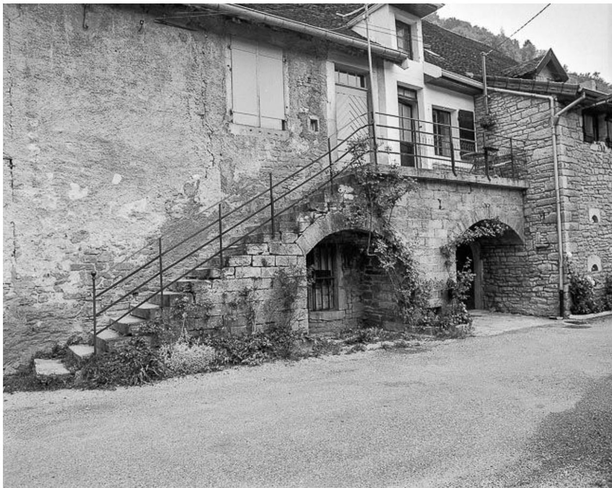
Façade antérieure : escalier à gauche de l'avancée.
