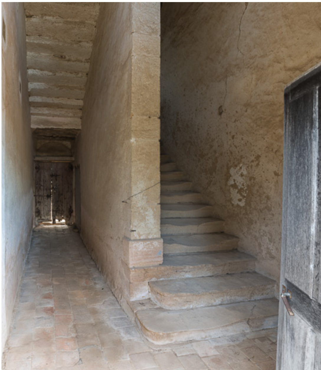
Vestibule et escalier
