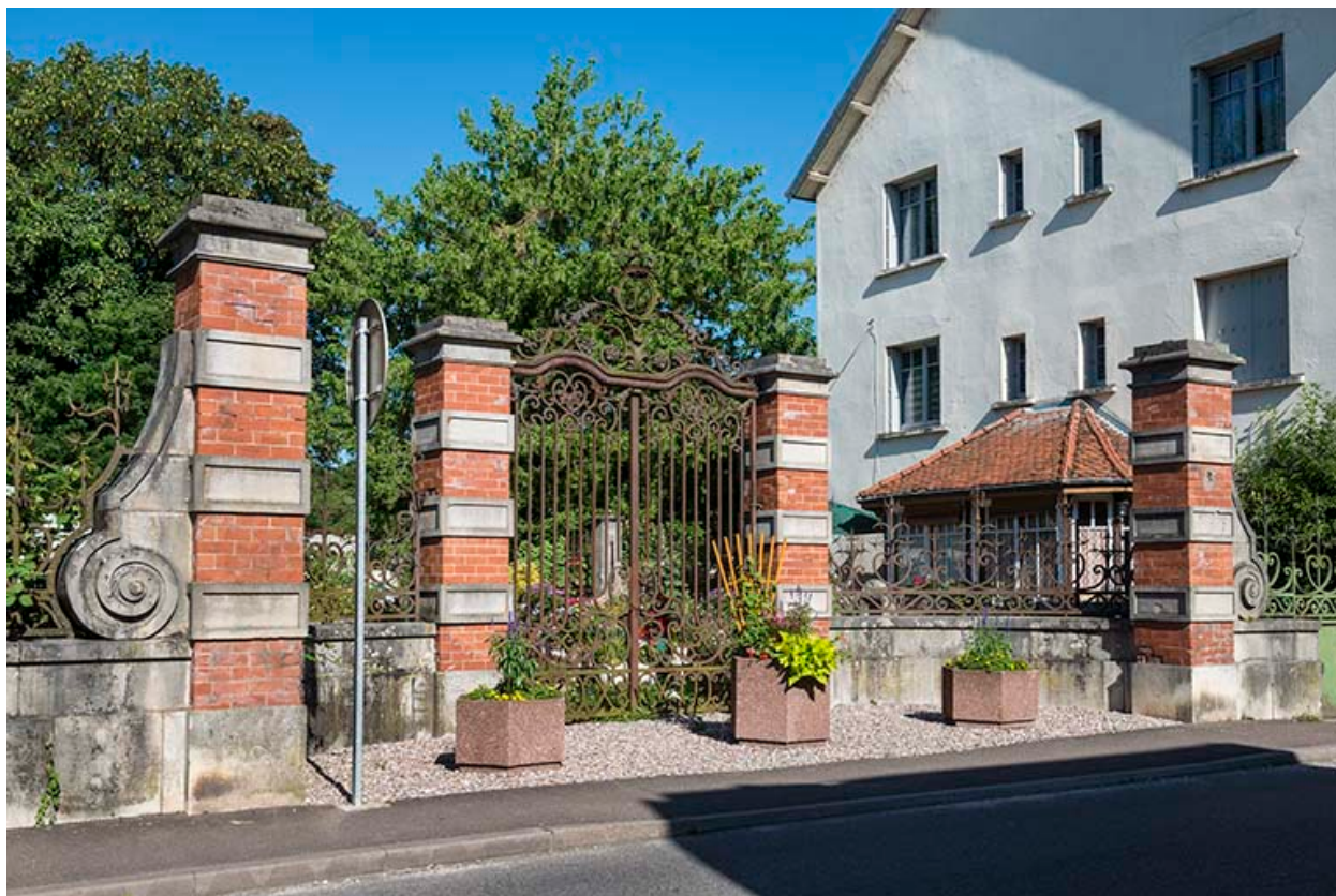
Clôture (grille) sur la rue Armand Paulmard.
