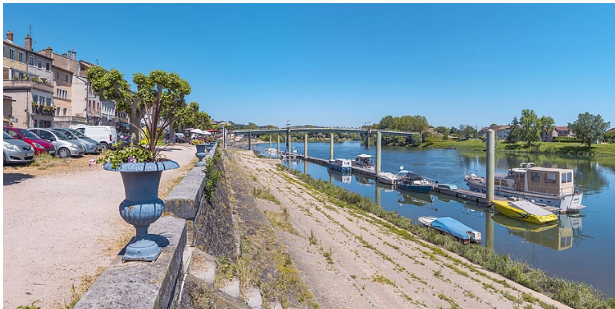
Vue d'ensemble des quais à gradins.
