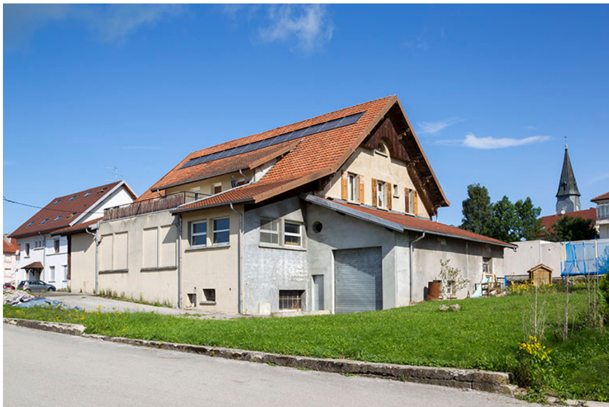
Façades postérieure et latérale droite.
