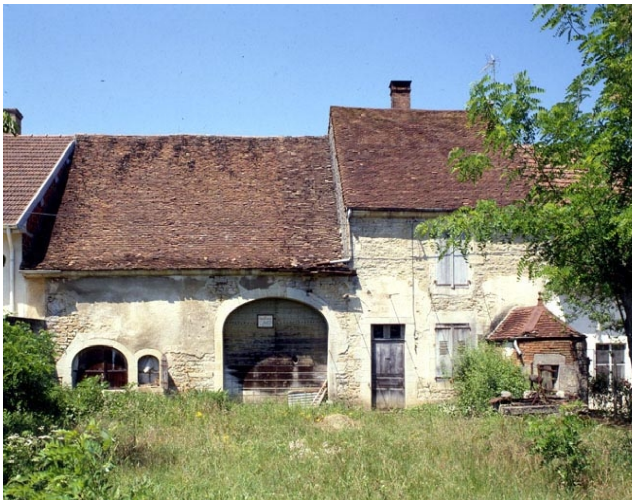
Façade antérieure vue de face en 1990.
