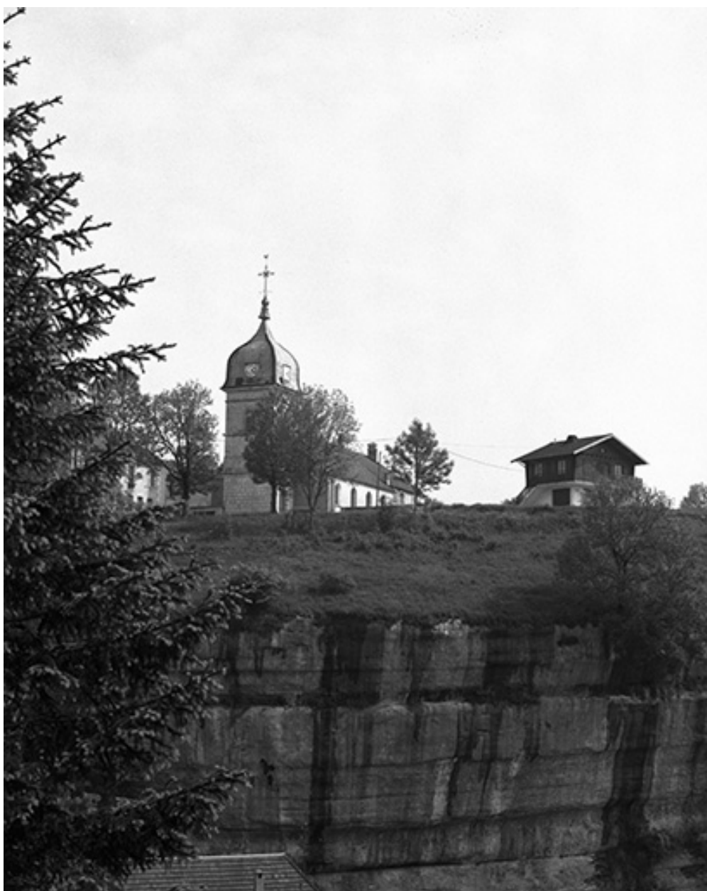
Façade antérieure et face latérale droite.
